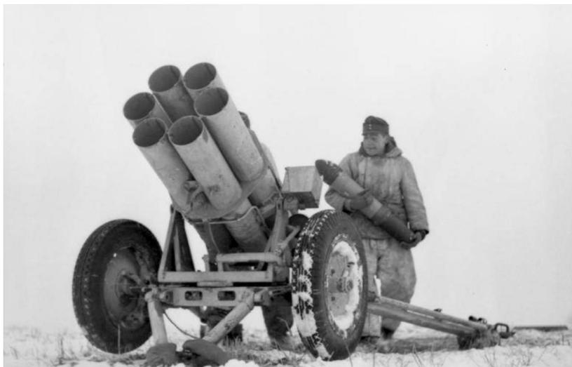
**Рис. 7.** 150-мм шестиствольный реактивный миномет Nb. W 41 обр. 1941 г. Восточный фронт
